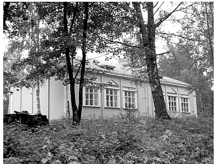
Puukoulu on laitettu hyvään kuntoon.
